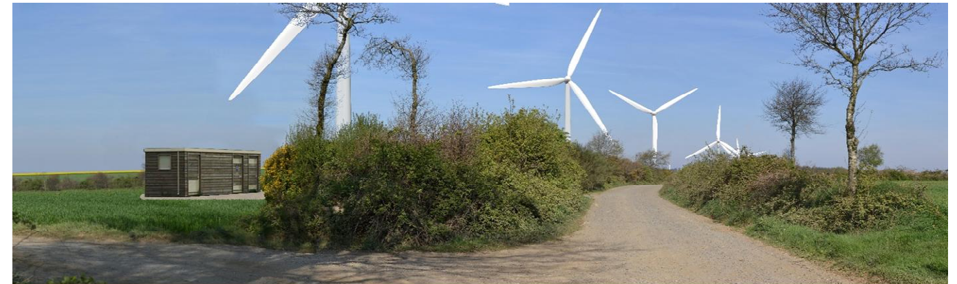
Figure 177 du poste de livraison
